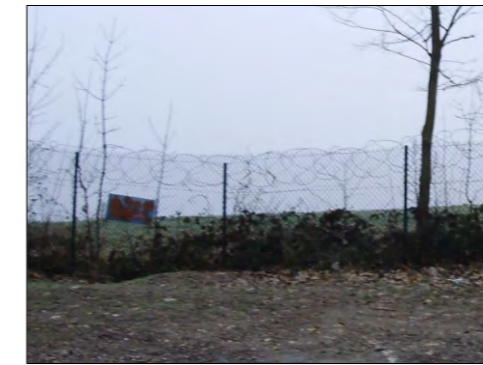
Matérialisation de l'interdiction d'accès par des panneaux, des barrières, une clôture complète et du fil barbelé
